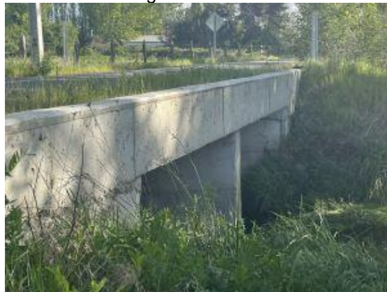
Fotografía N° 17, Reposición Puente Rauco, región del Ñuble
