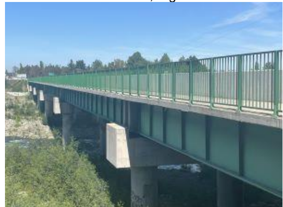
Fotografía N° 4: Puente Santa Isabel, región del Ñuble.
