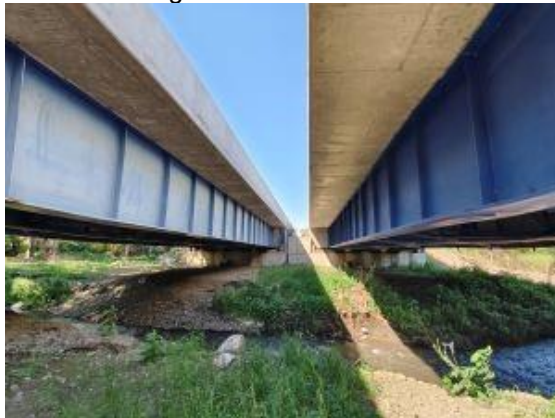
Fotografía N° 15, Reposición Puente Itraque, región de La Araucanía
