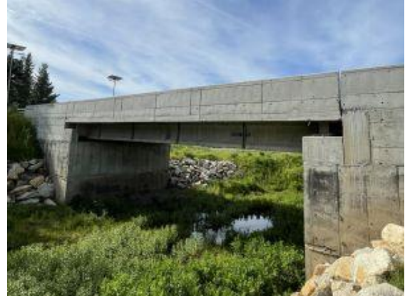
Fotografía N° 14, Reposición Puente El Manzano (SN), región de Ñuble
