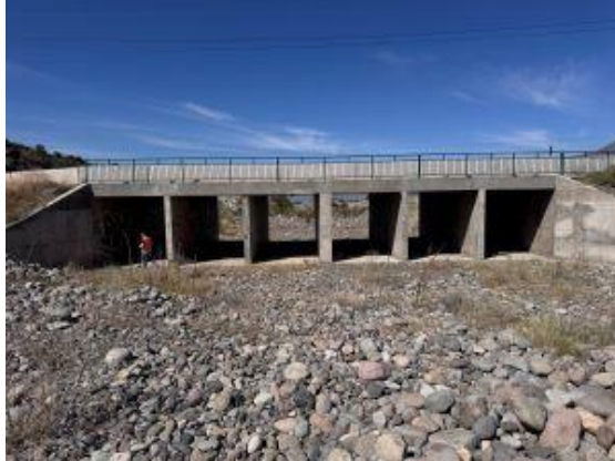
Fotografía N° 13, Reposición Puente Tres Puentes, región de Valparaíso
