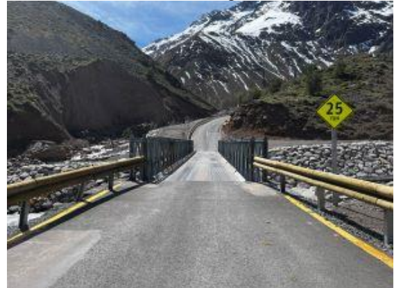
Fotografía N° 2: Puente modular El Morado, región Metropolitana de Santiago.
