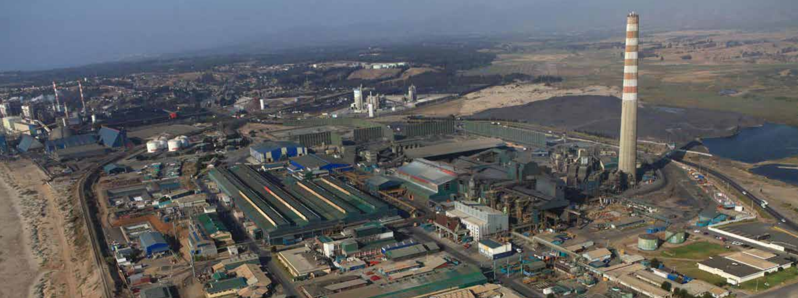
Fundición Ventanas de Codelco, bahía de Quintero, Valparaíso
