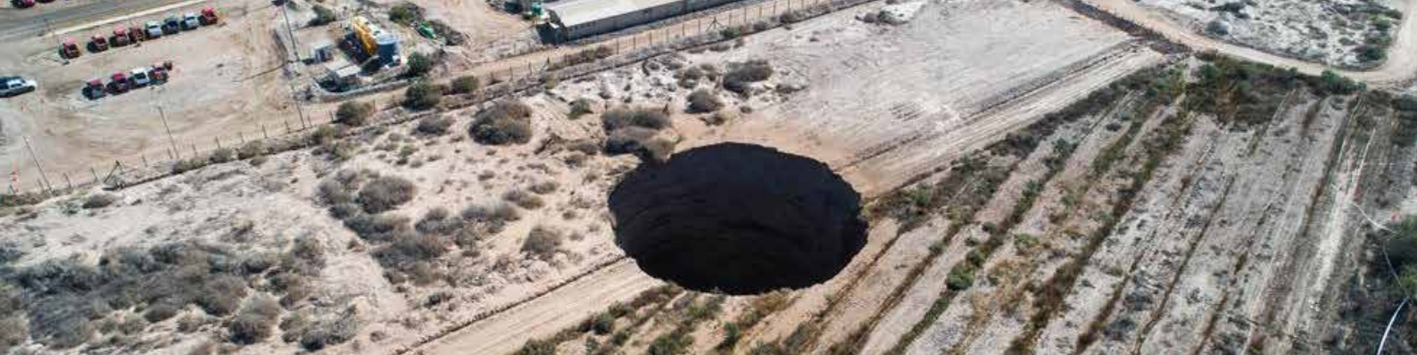
Socavón en Tierra Amarilla, Región de Atacama
