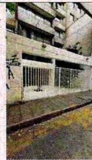
Fotografía N° 2: Acceso a edificio donde funciona el Hotel Clínico SpA.
